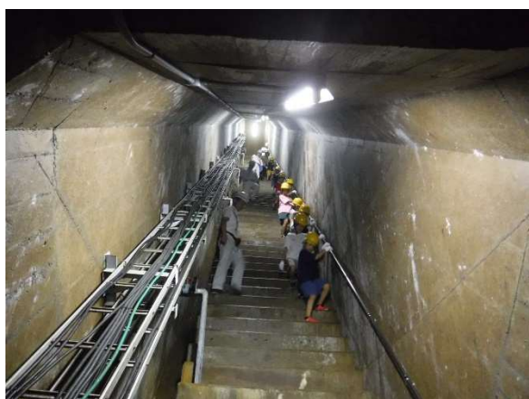
ダムの中（監査廊）を移動中
