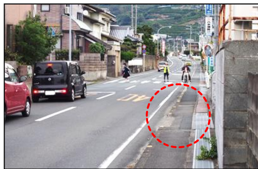
東側では歩道が狭く、段差も多いため車いす等が利用不可。また、路肩も狭いので自転車の通行が危険。
