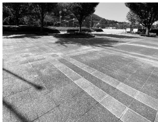
写真2 集合施設敷地内のタイル（インターロッキング）
