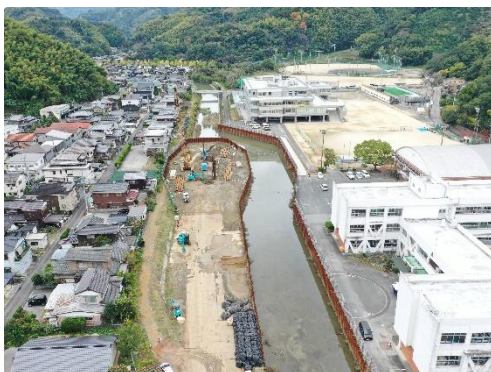
■河内川改修状況
