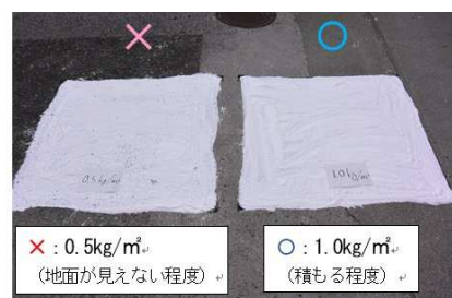
消石灰の散布箇所(幅1m)
