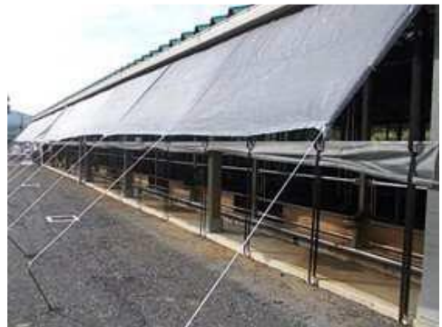
畜舎側面への遮光ネットの設置
