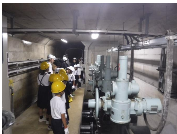
ダムの中（監査廊）を探検
