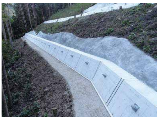
県営治山工事で伊予市の大栄地区に「地すべり防止工」を施工しました。
