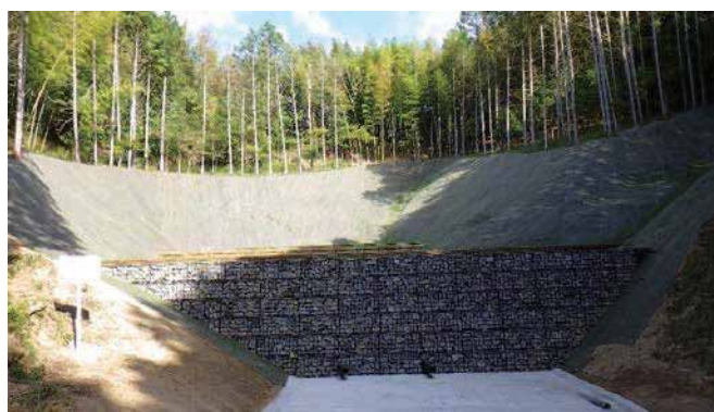
県営治山工事で松山市の猿川地区に「土留工」を施工しました。
