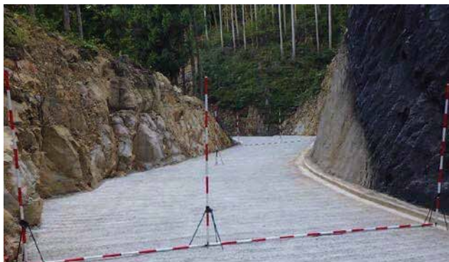
県営林道工事で伊予郡砥部町の林道「万年鵜崎線」を開設しました。
