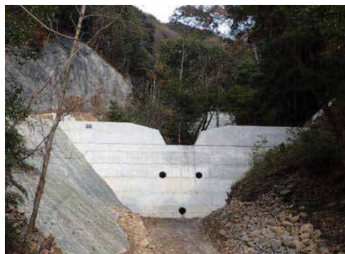
県営治山工事で伊予市の日尾野地区に「治山ダム工」を施工しました。
