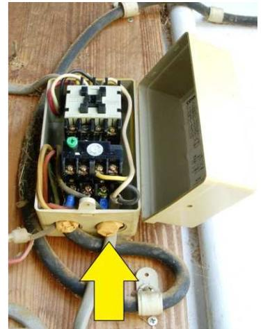
写真3 電磁開閉器等の穴を塞ぐ
