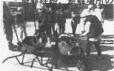
土嚢制作器での土嚢づくり
