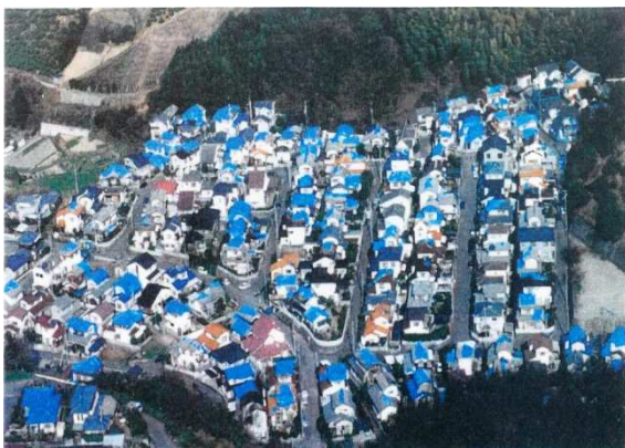
H13 芸予地震 屋根が損壊し、ブルーシートで応急処置した住宅（松山市）
