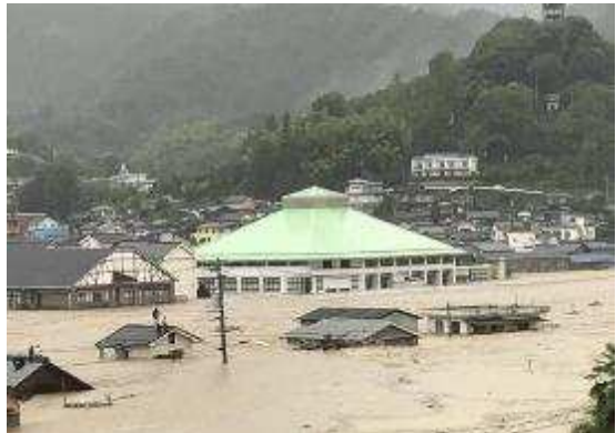
H30 西日本豪雨 肱川氾濫（西予市）
