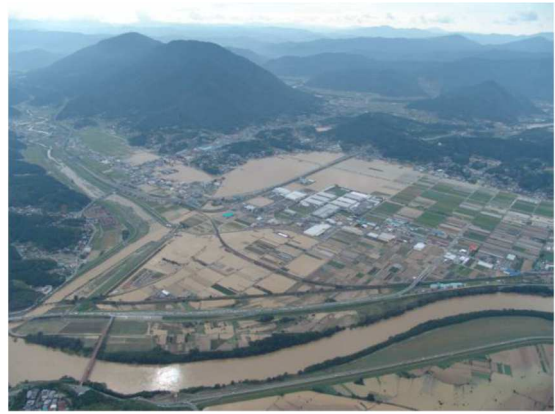
H16 台風第16号 肱川氾濫（大洲市）
