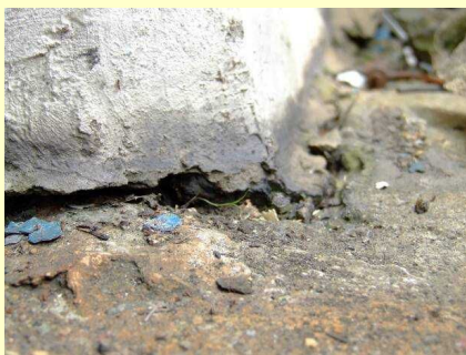
写真 1 - 4 - 1 .アルゼンチンアリの巣が確認されたコンクリートのひび割れ
