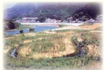
河川：河川改修により失われた環境に対する代償措置として自然環境を復元しています
