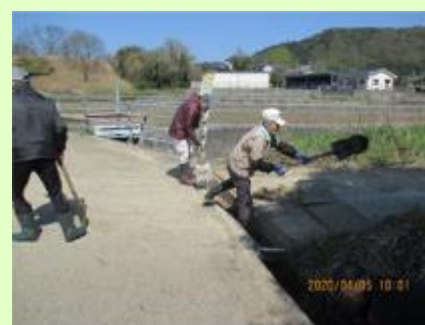
水路の泥上げ
