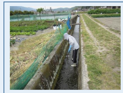
水路の泥上げ
