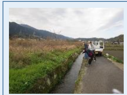
水路の点検・機能診断
