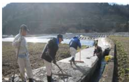
【農道舗装自己施工】
