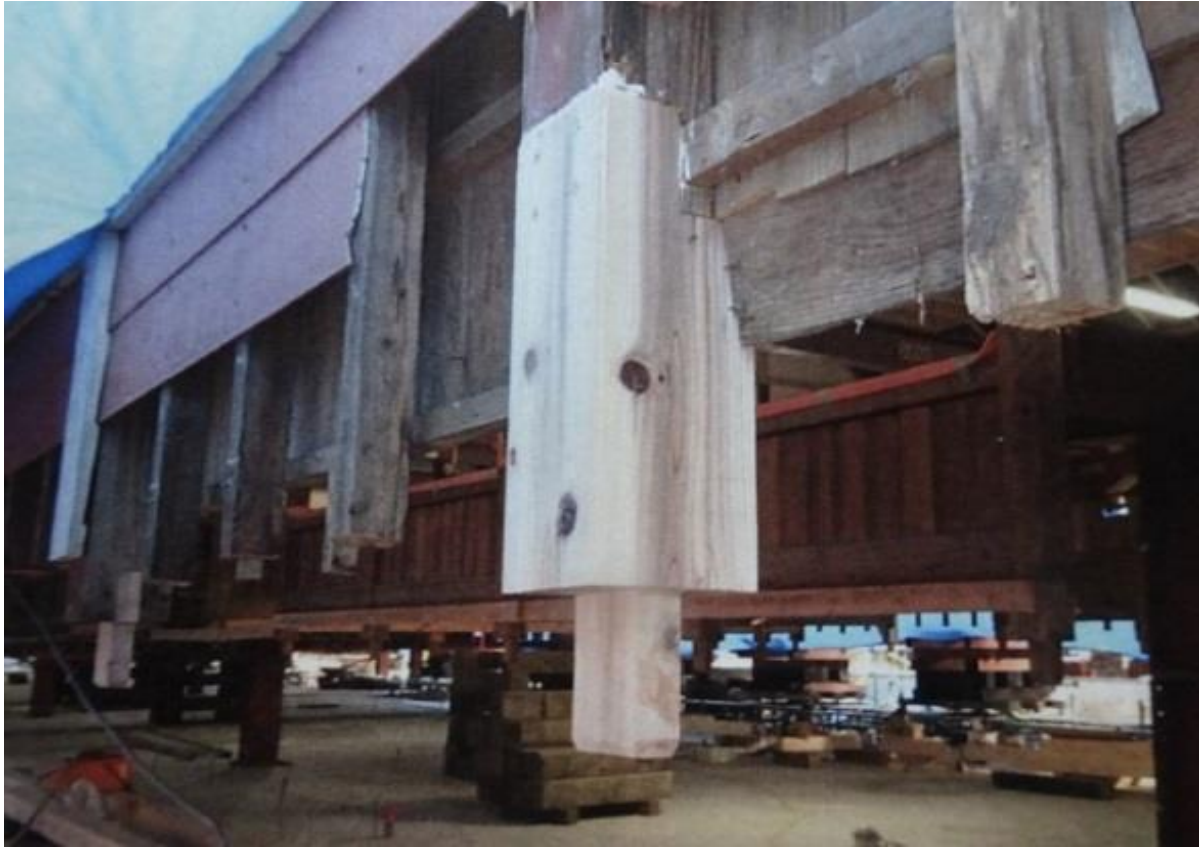
傷んだ土台部分の補修
