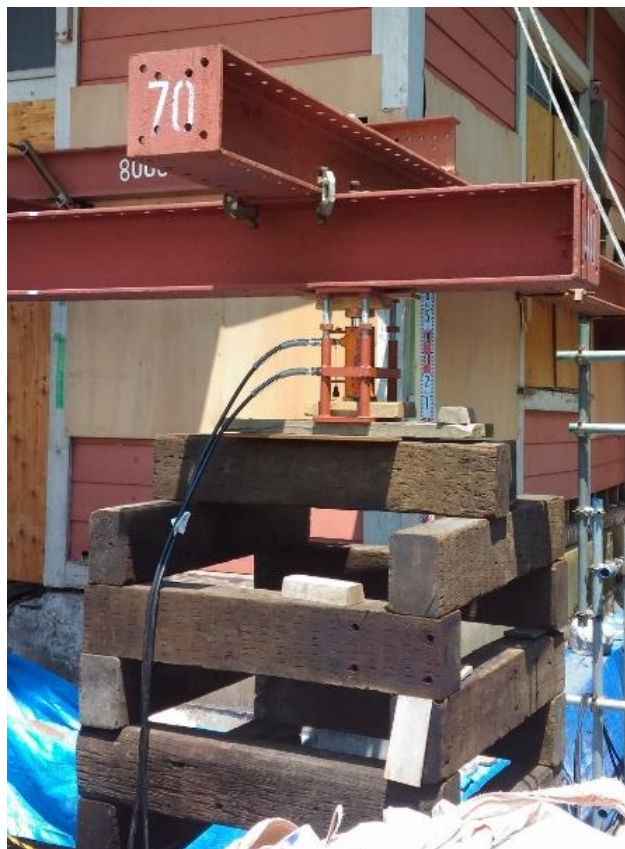
校舎を持ち上げる 油圧ジャッキ
