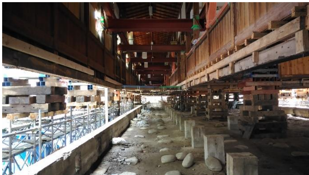
基礎から約1.2m持ち 上げられた校舎
