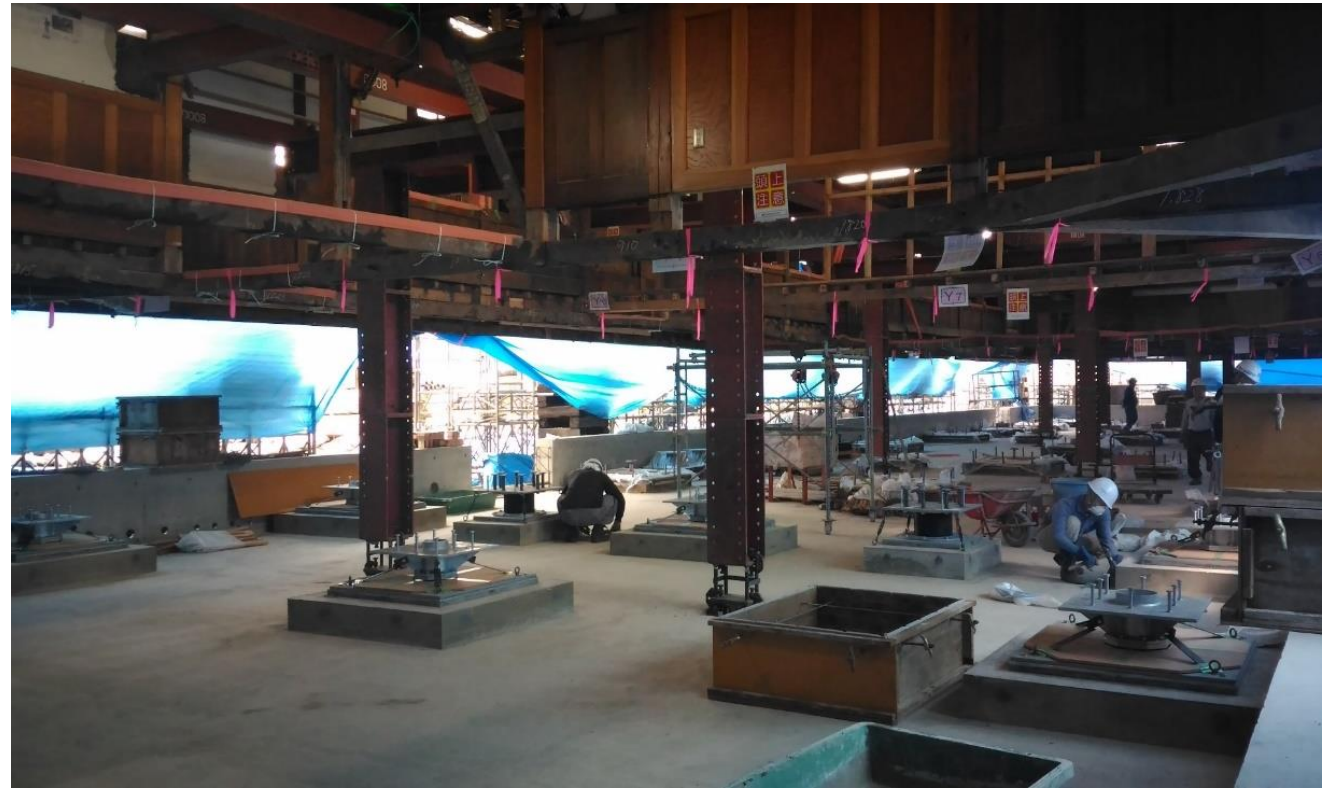
免震装置の工事
