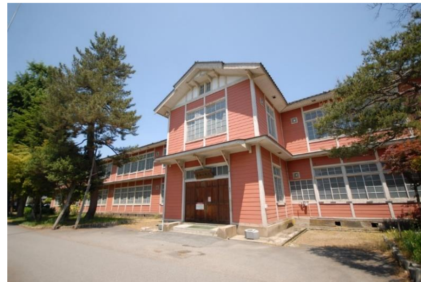
耐震改修前の第一校舎
