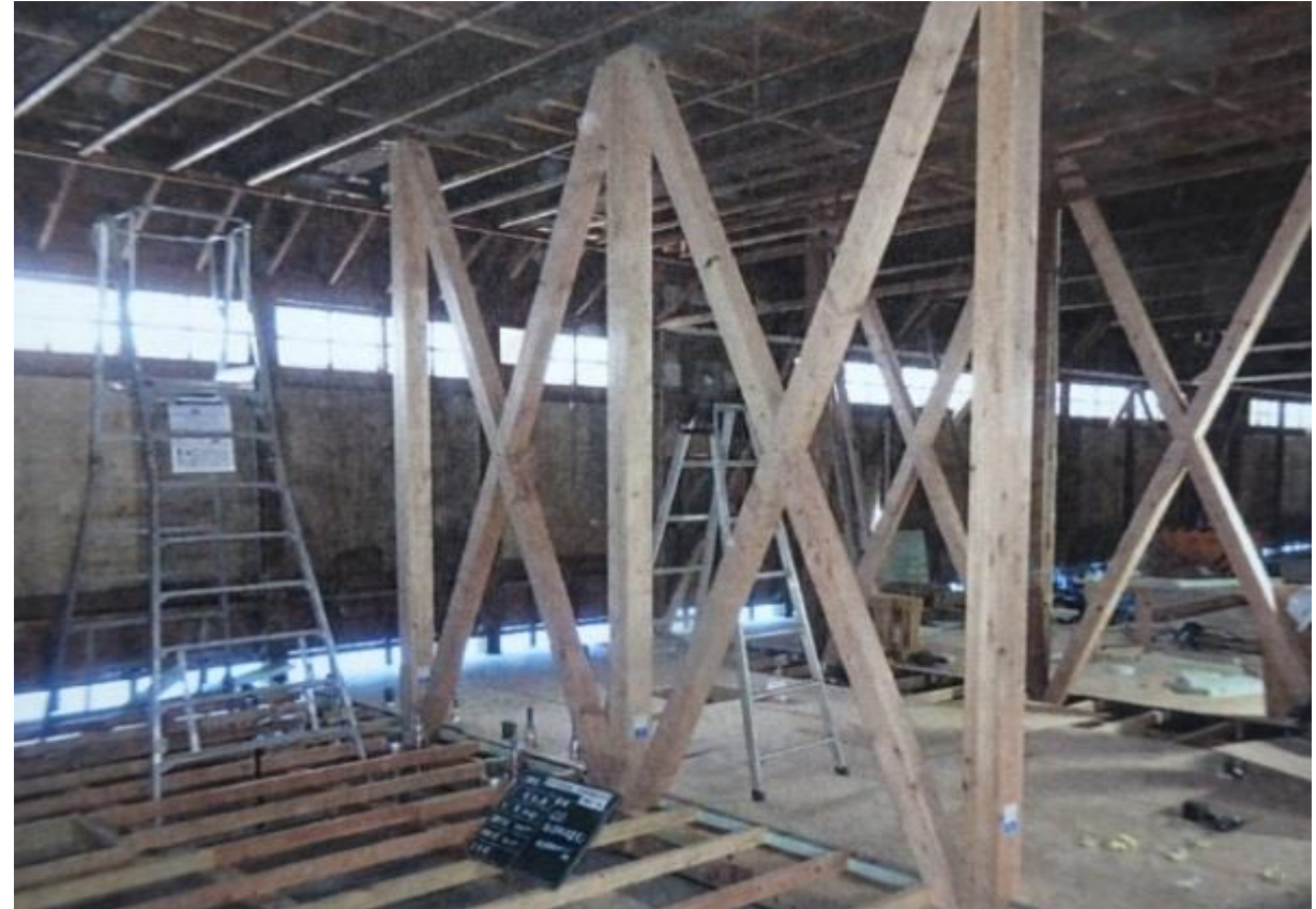
筋交いの新設
