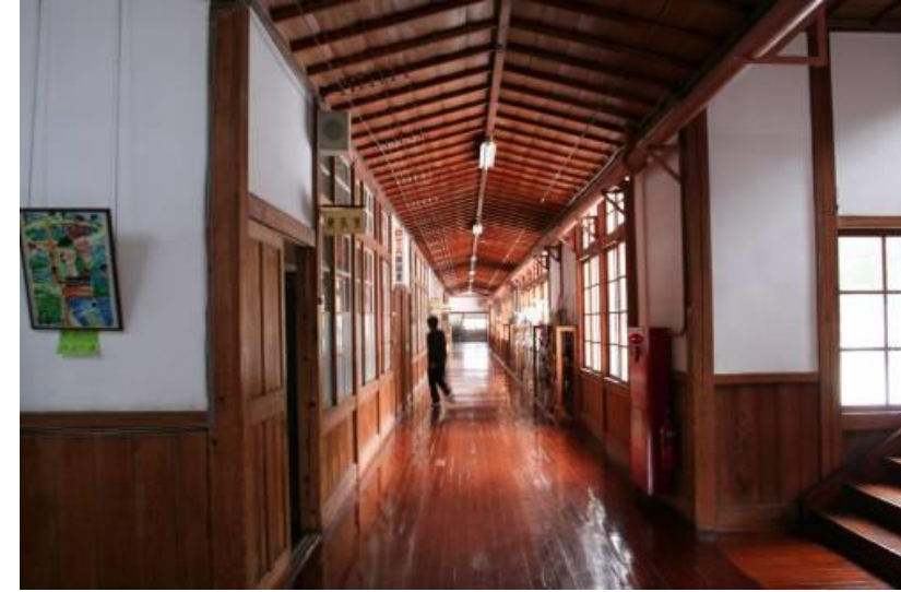
耐震改修前の廊下
