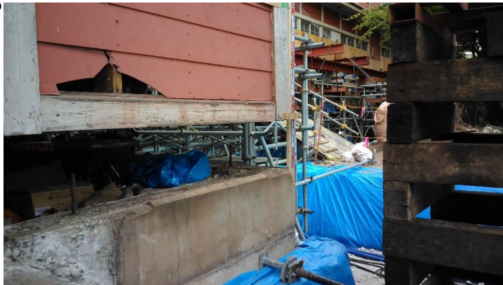
基礎から約40cm持ち 上げられた校舎
