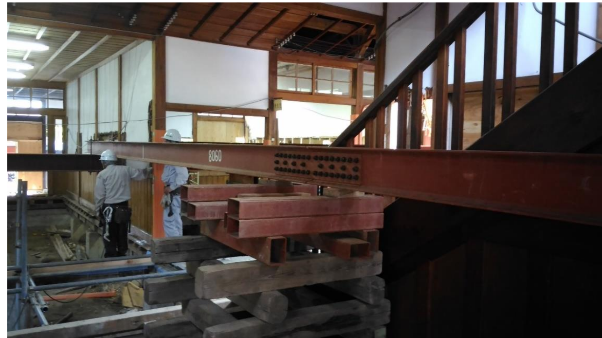
ジャッキアップのため校舎内を通る鉄骨
