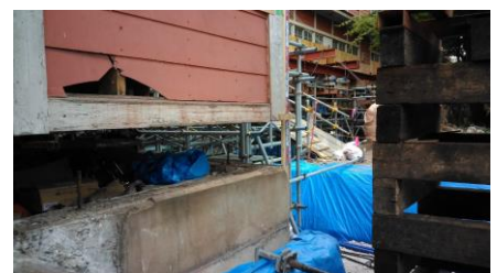
基礎から持ち上げられた校舎
