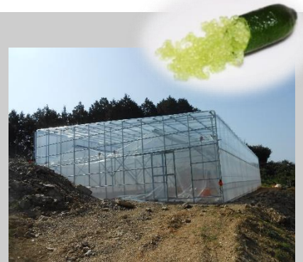
【事業を活用して新設したハウス】
