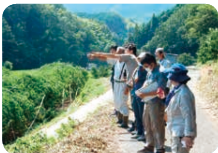
集落内の点検活動
