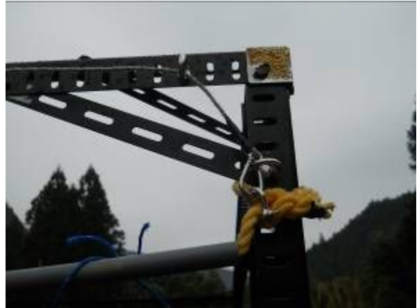
写真 9-4 引き上げ式ゲートロック構造
