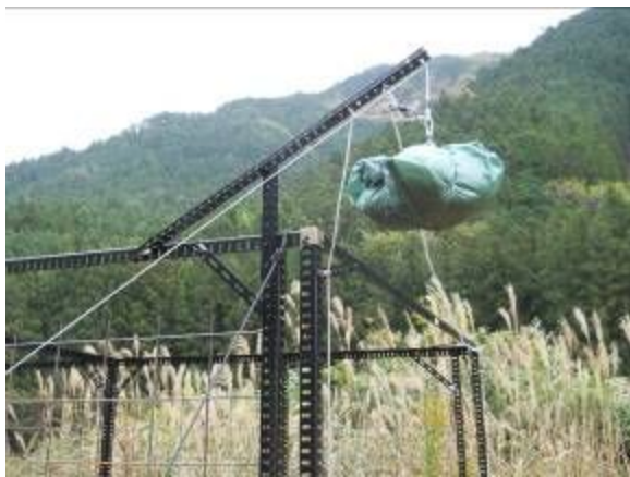
写真 9-2 ハンガーからの土嚢のつり下げ
