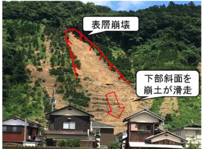
図一 2.21 崩壊土砂が下部斜面を滑走した事例（宇和島市吉田町沖村）
