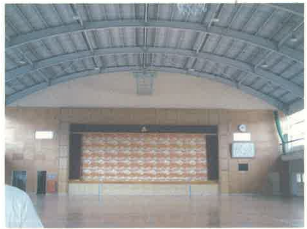
④体育館内部
