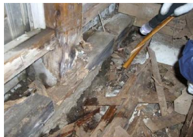
床下の腐朽
