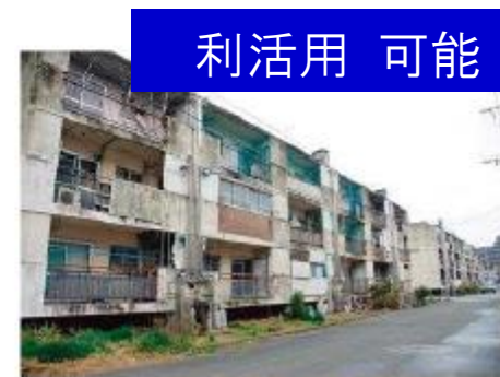
共同住宅の空き家
