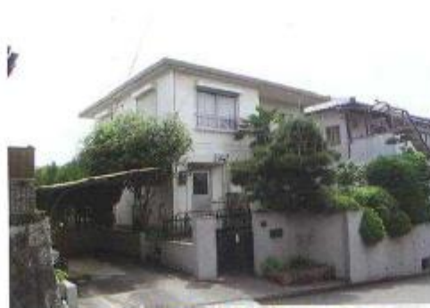
まだ使用できる空き家
