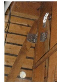
2階洋室金物取付2
