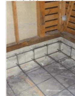
1階洋室配筋基礎
