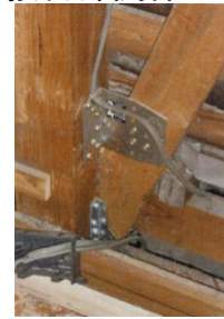
2階洋室金物取付1
