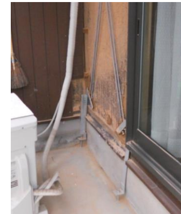
筋かい金物による補強
