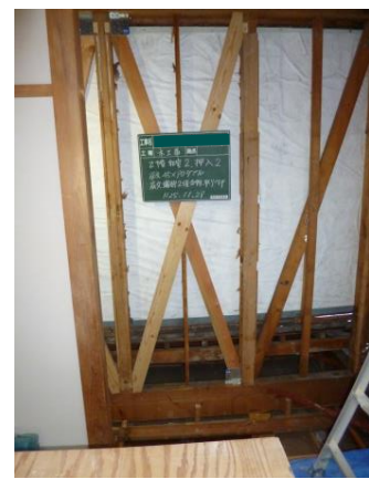
筋かいによる補強
