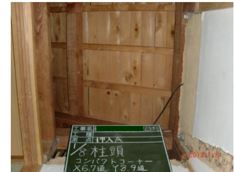
筋かい金物による補強
