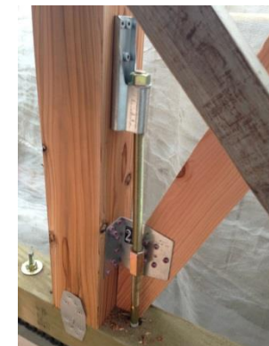
ホルダウン金物などによる補強
