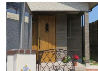
(完成:外壁の張替え等)
