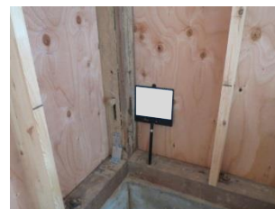
(構造用合板による補強)
