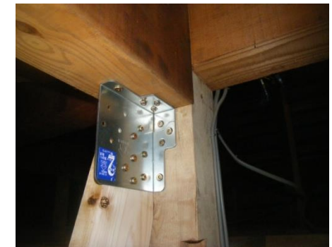
筋かい金物による補強
