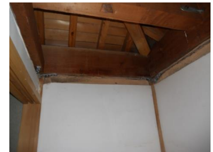
筋かい金物による補強
