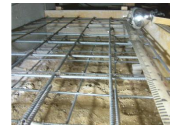
工事中 (配筋設置状況)
