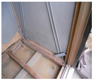
押入れ内の壁を筋交いと構造用合板で補強
