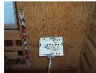
(構造用合板による補強)
