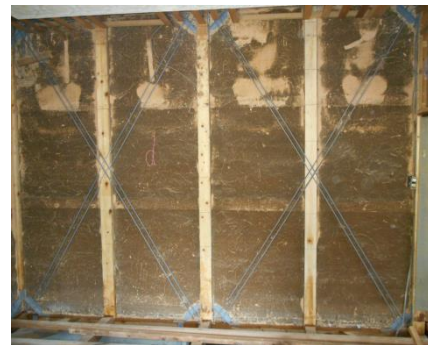
筋かいによる補強
