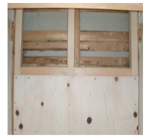
押入れ内の壁を補強
