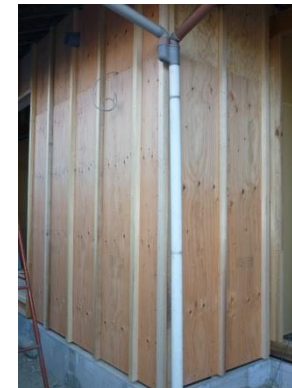
構造用合板による補強
