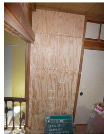
構造用合板による補強
