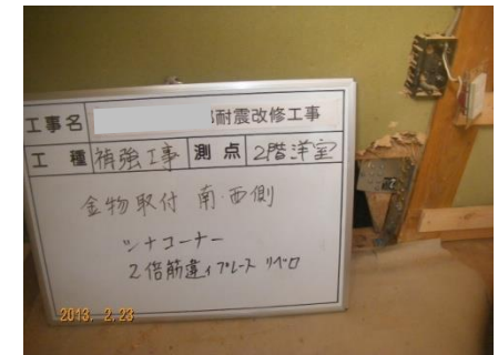
筋かい金物による補強
