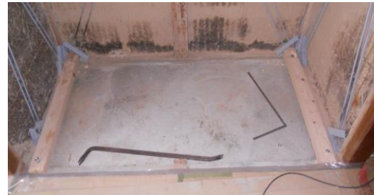
押入れ内の壁を筋交いで補強
