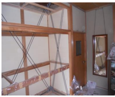
押入れ内の壁を筋交いと構造用合板で補強
