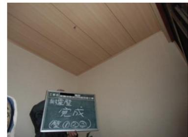
玄関の壁を筋交いと構造用合板で補強
