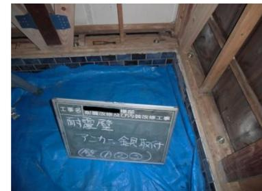
筋かい金物・アンカー等による補強
