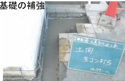
既存基礎に鉄筋コンクリート基礎を増し打ち
