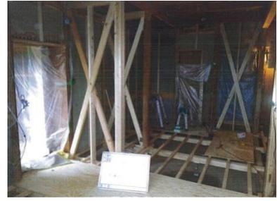
内壁を筋交いと構造用合板で補強
