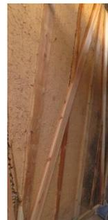
補強壁、又は筋かいで補強筋かい金物(工事中)
