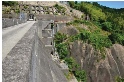
管理用階段通路
