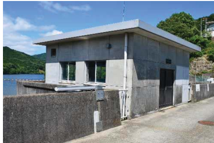
取水ゲート操作室
