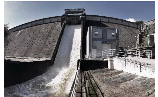
ゲート操作によるダムからの放流状況
