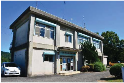
ダム管理事務所
