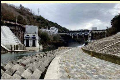
スタート地点：鹿野川ダム直下
