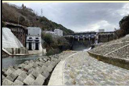
スタート地点：鹿野川ダム直下
