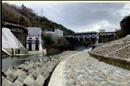
スタート地点：鹿野川ダム直下
