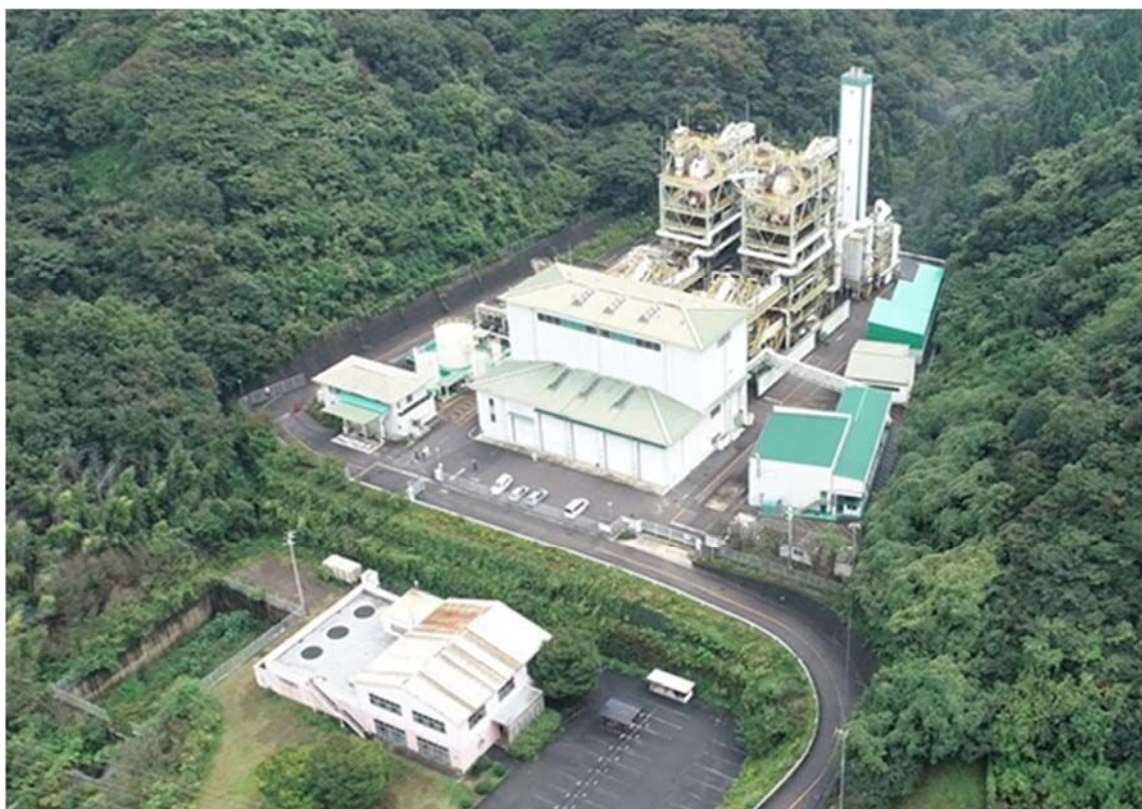
一般財団法人愛媛県廃棄物処理センター東予事業所全景
