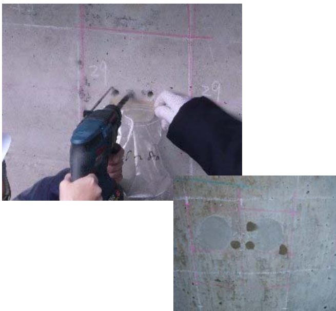
図4 ドリル粉採取状況と補修後の状況
