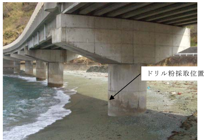
図6 須沢大橋の状況
