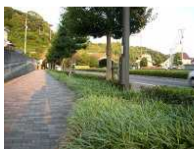
防草工法を導入した植樹帯
