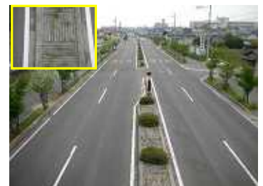
水源涵養型(砂利敷き工)
