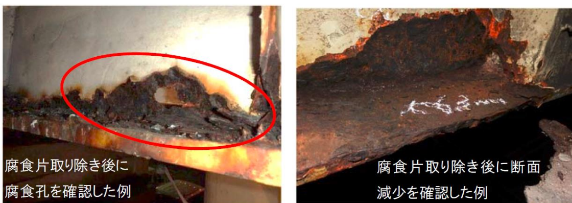
腐食片を取り除いた状態の例（主桁）
