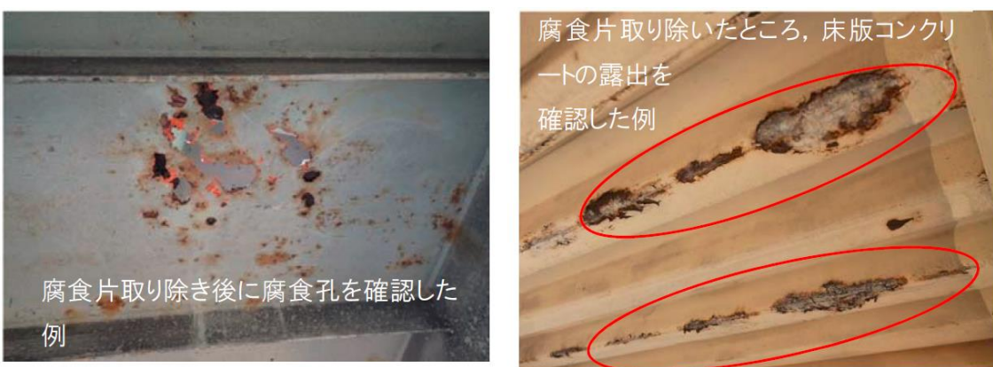
腐食片を取り除いた状態の例（床版）
