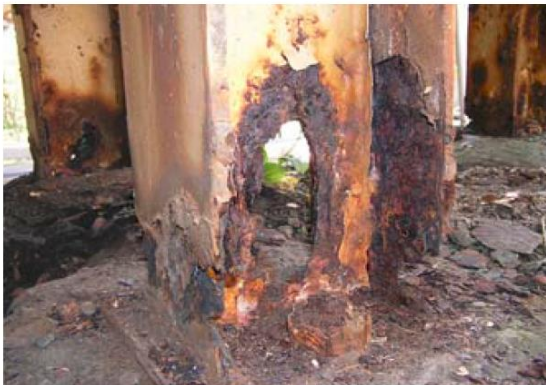
腐食片を取り除いた状態の例（下部）
