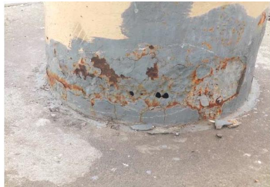
腐食片を取り除いた状態の例（下部）
