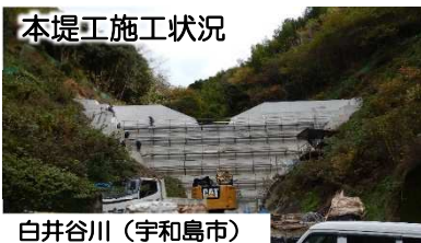
本堤工施工状況 白井谷川(宇和島市)
