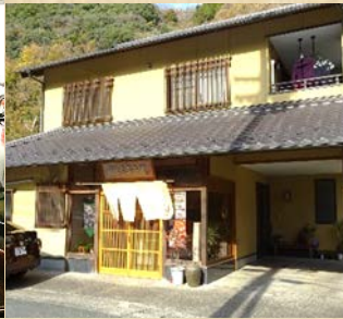
改修された店舗
