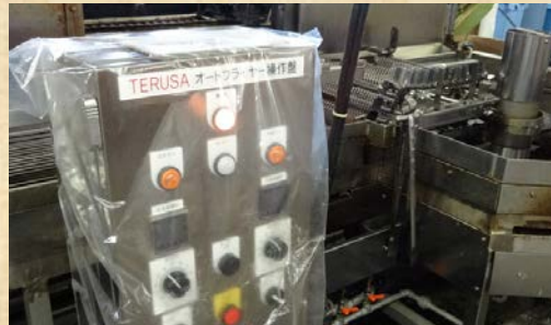
修繕・入替えされた設備
