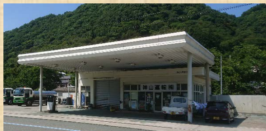
復旧後の写真
