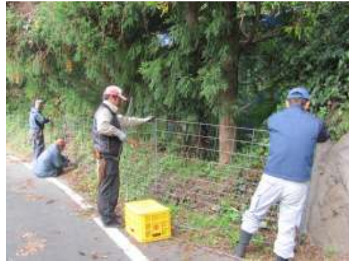
集落共同で侵入防護柵を設置
