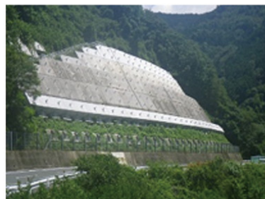
法面防災対策(アンカー工)
