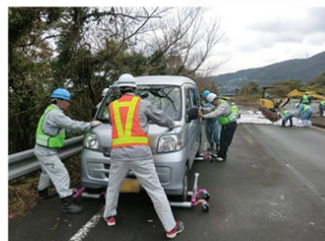
車両移動 (ゴージャッキ使用)
