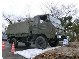
段差すりつけ (土のう使用)
