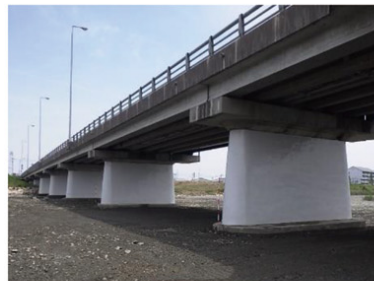
橋梁耐震対策(橋脚巻立工)
