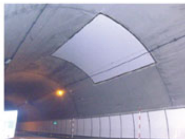
トンネル保全対策
