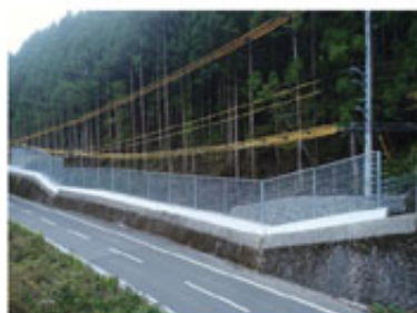
法面防災対策(落石防護柵工)
