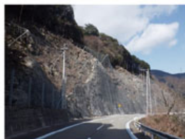
法面防災対策(ロックネット工)
