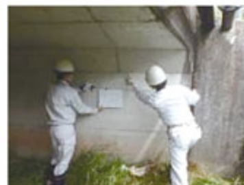
【近接目視による定期点検】
