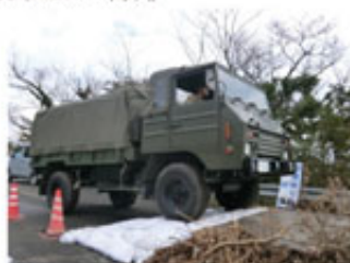
段差すりつけ (土のう使用)
