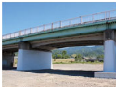
橋梁耐震対策(橋脚巻立工)
