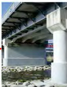
橋脚補強(コンクリート巻立)
