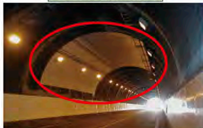
剥落防止工(炭素繊維シート貼付け)
