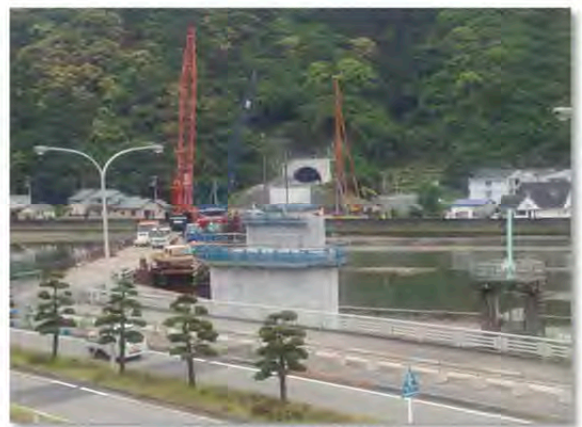
建設中の宇和島道路
