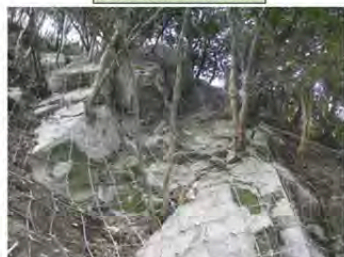
落石防止工(ワイヤーロープ掛け)
