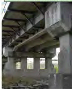
橋脚補強(コンクリート巻立)
