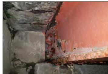
【橋梁主桁鋼材の腐食】
