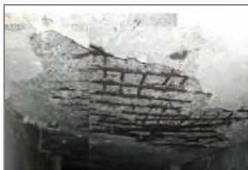
【橋梁床板の鉄筋露出】
