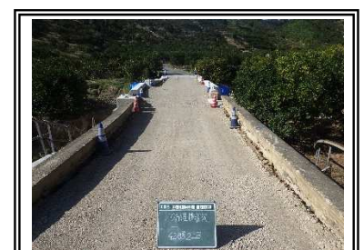
応急復旧完了
