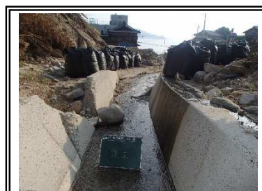
大型土のう設置
