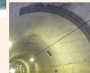
トンネル壁面の補修
