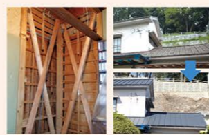
耐震改修(筋かい追加) 耐風改修(瓦屋根の葺き替え)
